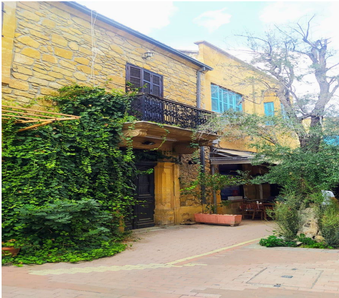
Bild 7. Typische Architektur in Laiki Gitonia. Quelle: Stando Ltd.
