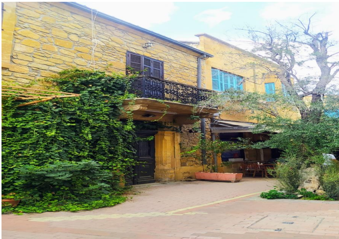
Εικόνα 7. Όψη από την παραδοσιακή γειτονιά της Λαϊκής Γειτονιάς, όπου φαίνεται η παραδοσιακή κυπριακή αρχιτεκτονική. Πηγή: Stando Ltd.
