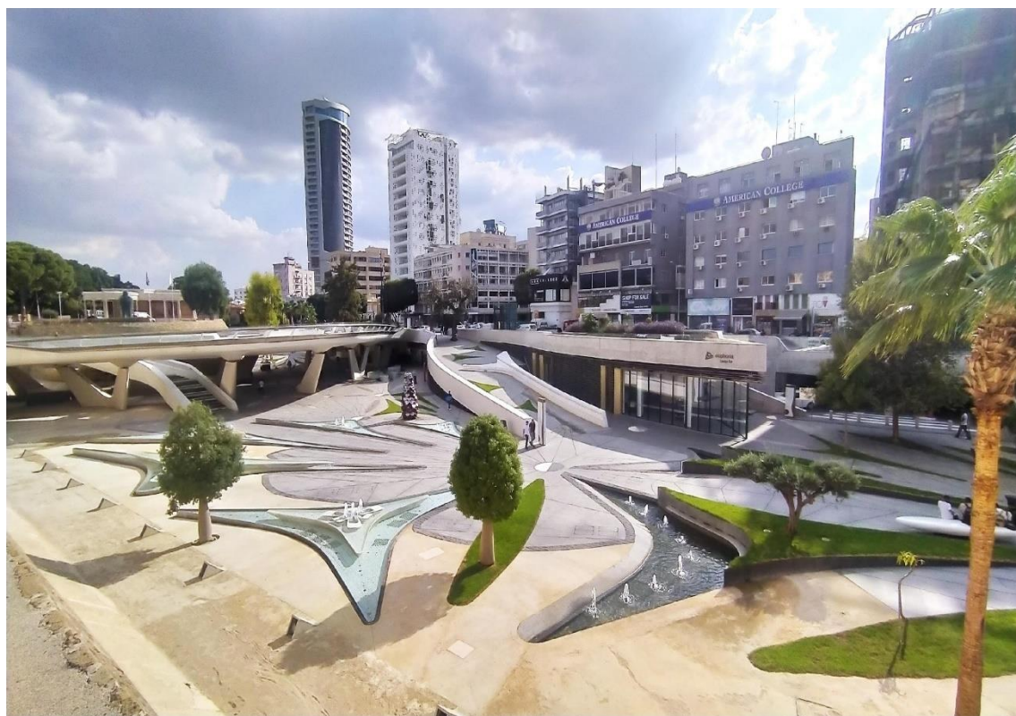
Εικόνα 4. Όψη από την ανακαινισμένη Πλατεία Ελευθερίας της Λευκωσίας. Πηγή: Stando Ltd
