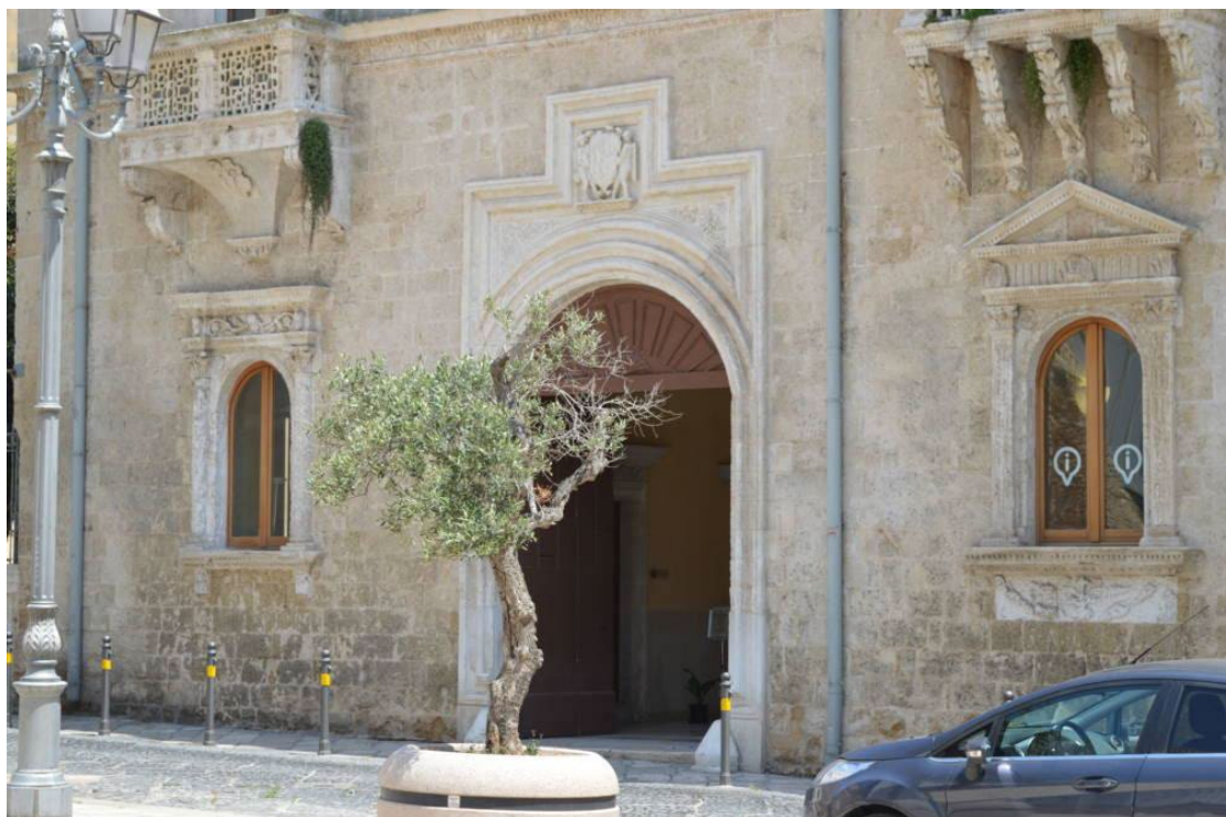
Immagine 2. La facciata
